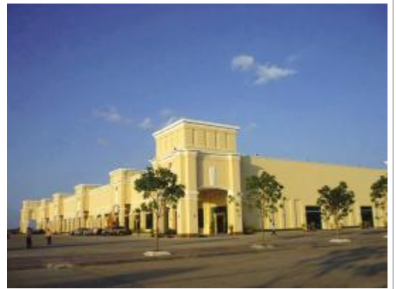
图为柬埔寨国家级重点开发工程——钻石岛城项目
