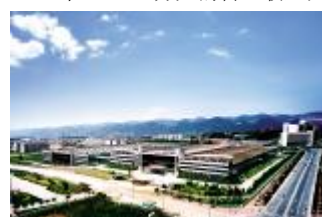
图为：中国西部最大的空调生产基地——格力电器重庆公司。
